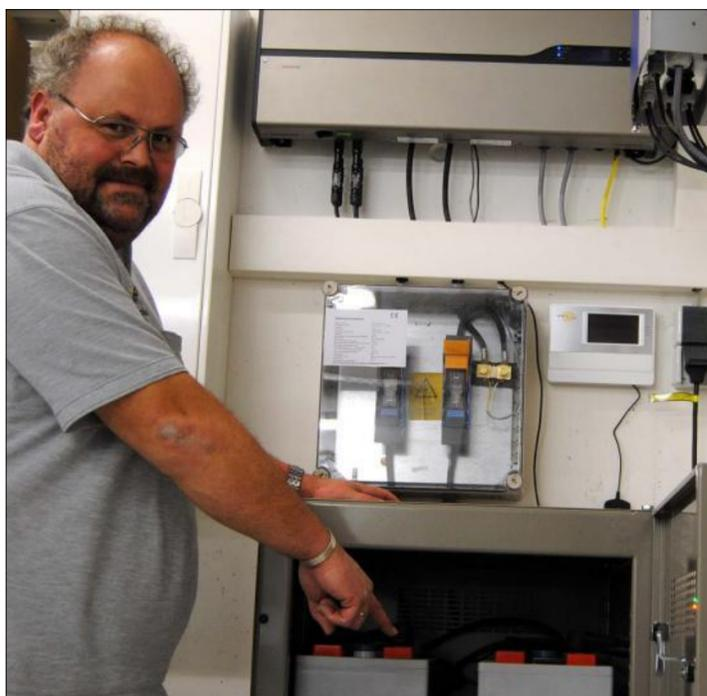
Klaus Schütz zeigt den Würth Solar-Speicher: In diese Batterien fließt die überschüssige Energie und je nach Bedarf wieder ins eigene Stromnetz. Sind die Akkus voll, wird der Strom ins öffentliche Netz geleitet – gegen Barres wohlge-merkt.
