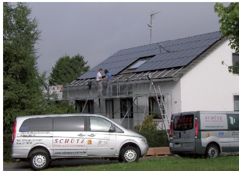
Einfach auf die Sonne setzen: Die Anlagen von Schütz Elektro- und Sicherheitstechnik arbeiten effektiv und zuverlässig.
