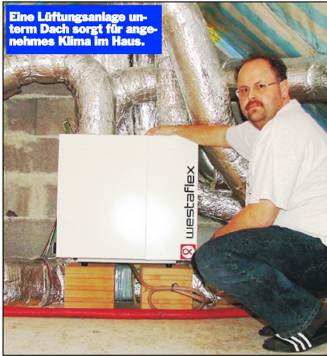
Mit zwei Wärmepumpen, im Erdreich verlegten Rohren und einer Wärmerückgewinnungsanlage heizt Elektromeister Klaus Schütz sein Wohn- und Geschäftshaus in Kalschingen. Fotos: Hertle
