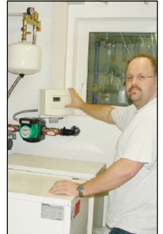
Mit zwei Wärmepumpen, im Erdreich verlegten Rohren und einer Wärmerückgewinnungsanlage heizt Elektromeister Klaus Schütz sein Wohn- und Geschäftshaus in Kalschingen. Fotos: Hertle
